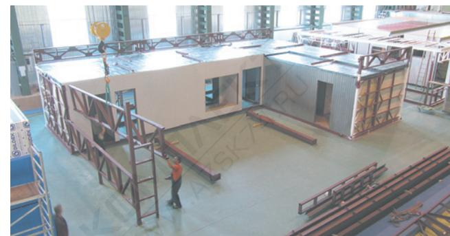
**Этап 2** Монтаж сэндвич-панелей, кровельного комплекта и заполнение оконных и дверных проемов
